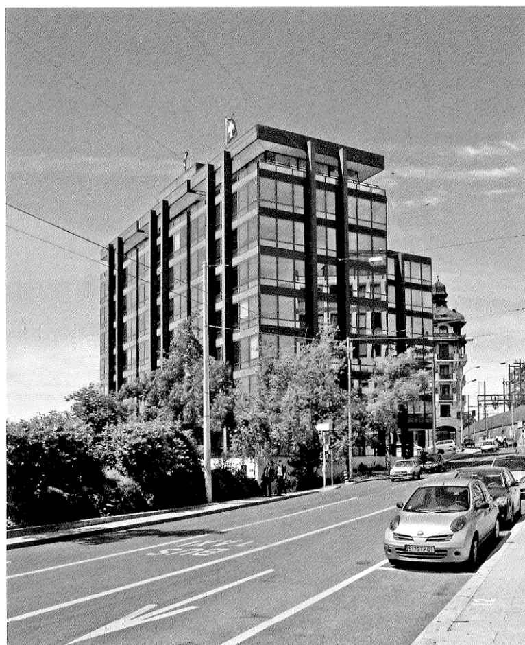
Oben: Patinoire des Vernets in Genf, 1954–58, Hauptfassade mit Tragwerk der Haupttribüne. Bild: François Maurice Unten: Das 2011–16 aufgestockte und energetisch ertüchtigte Bürohaus der Fédération des syndicats patronaux in Genf, 1959–66. Bild: Bello & Yurdakul
