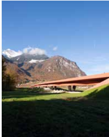
VUE DE L'OUVRAGE DEPUIS LE SUD-EST | DAS BAUWERK VON SÜDOSTEN GESEHEN
