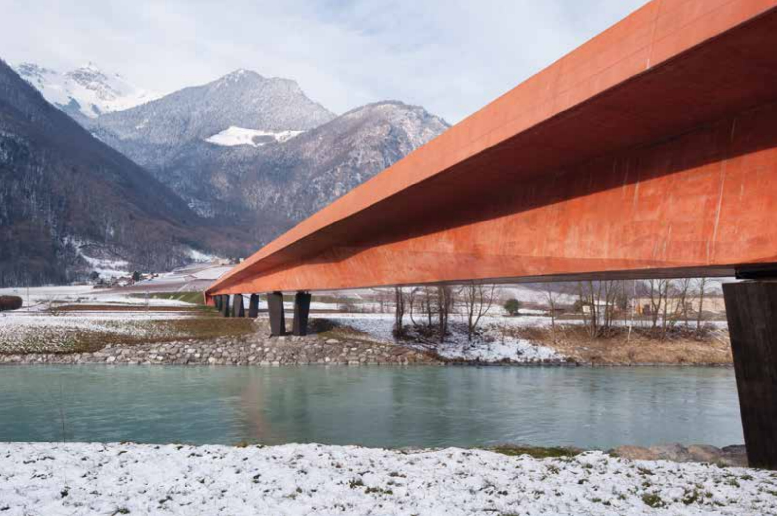
Il disegno delle sezioni dell'impalcato varia in relazione alla lunghezza delle campate
