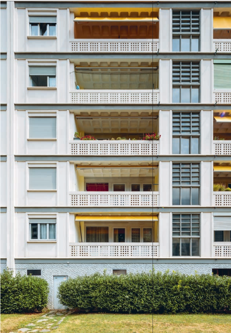
Vernier, La Cité Balexert, détail d'une façade en éléments préfabriqués, Jean-Jacques, Pierre et Robert Honegger, 1957–1962. Photo : Nicolas Schopfer
